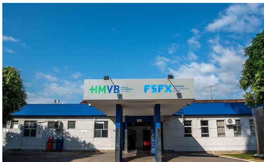
Figura 50: Hospital Municipal de Timóteo
